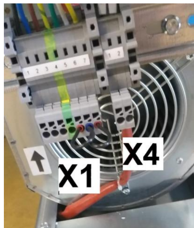
Fig. 3 (morsettiera ventilatori)
